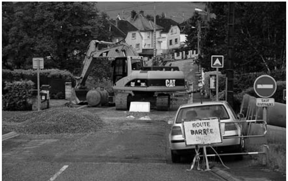
Travaux rue des Vergers
