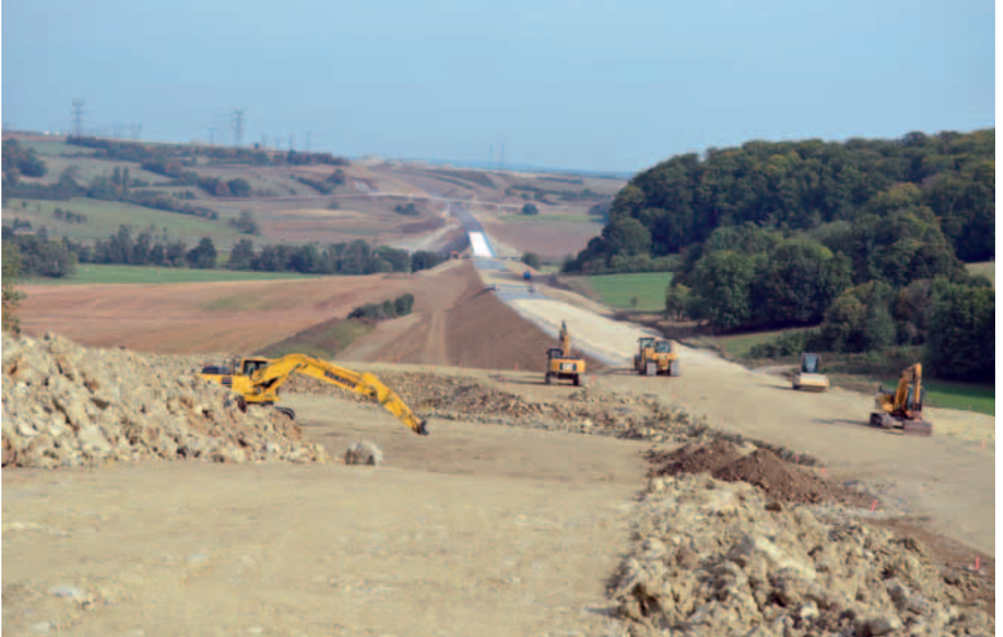
Vue panoramique du chantier de la LGV côte de Dolving avec au fond le Bergholz
