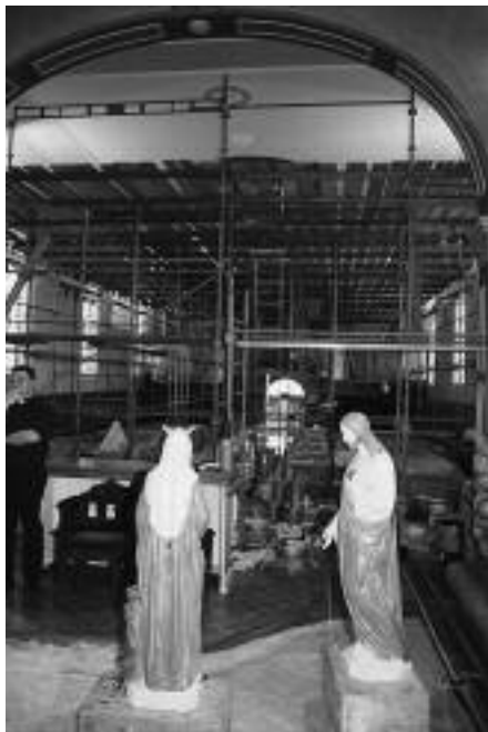
Travaux de restauration de l'église
