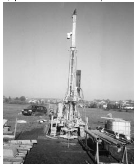
Forage pour le TGV dans la vallée de la Sarre
