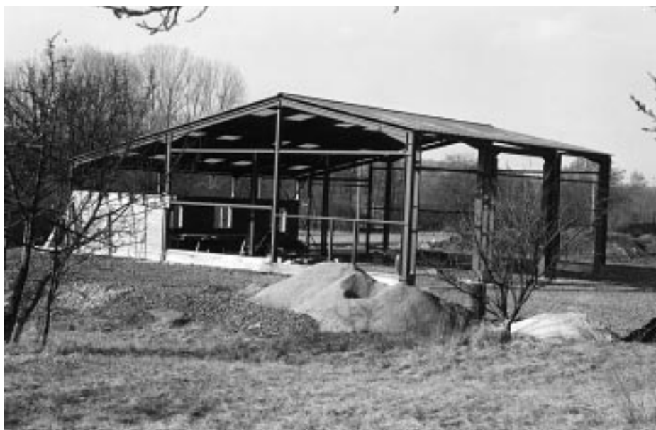
L'atelier communal en cours de construction (achevé à l'heure actuelle - voir le "mot du maire")
