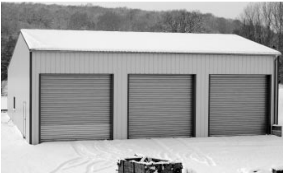
Entrepôt communal et local des sapeurs-pompiers.
