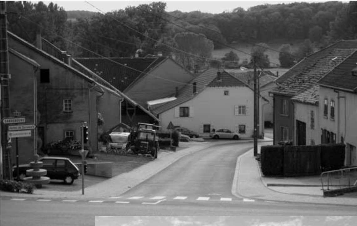
La rue de la Sarre réhabilitée
