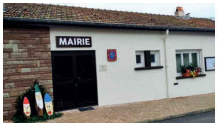
Après travaux de peinture (photo ci-dessous)
